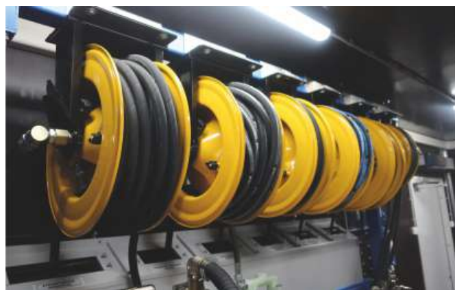
Расположение катушек для 40-ка футовых контейнеров
